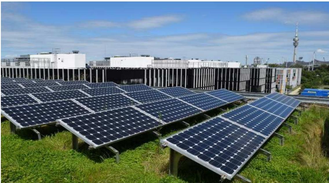
Abbildung 3: Gründach in Kombination mit Photovoltaik
