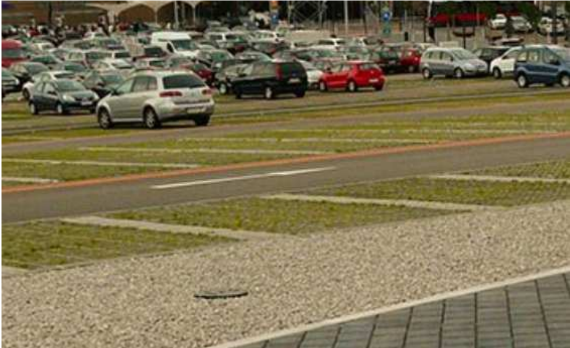
Abbildung 6: Begrünte Parkfläche beim EKZ in Gerasdorf
