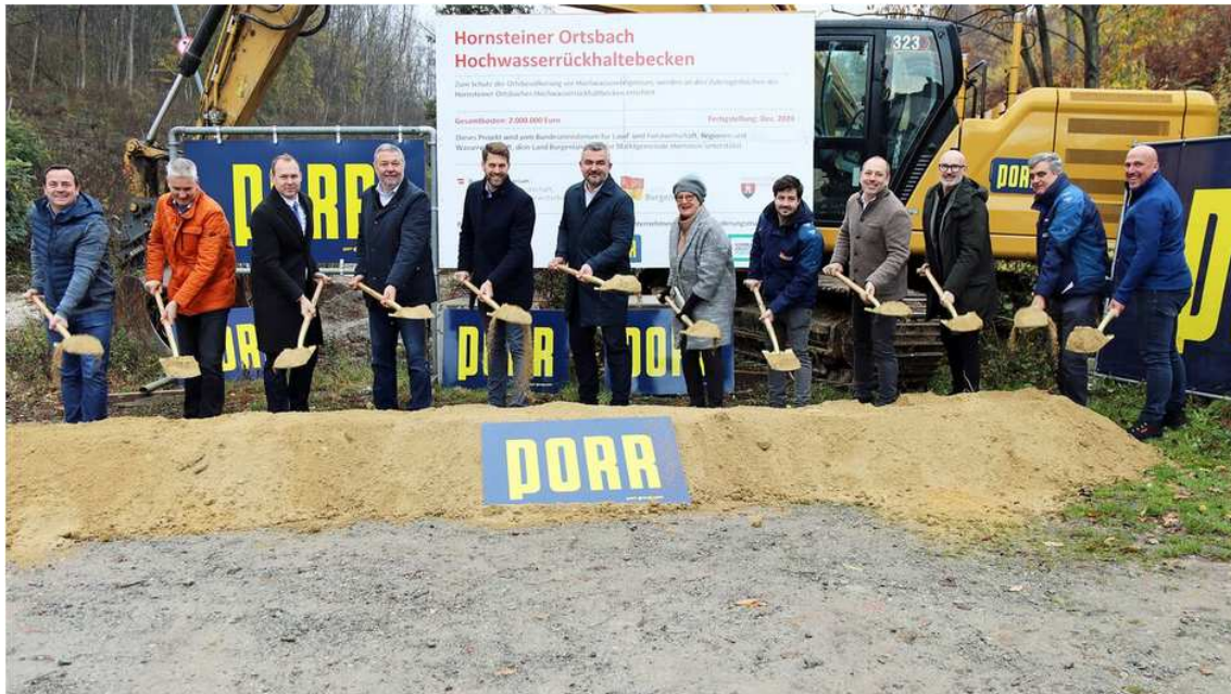
Abbildung 26: Spatenstich Hochwasserschutzprojekt Hornstein 2022
