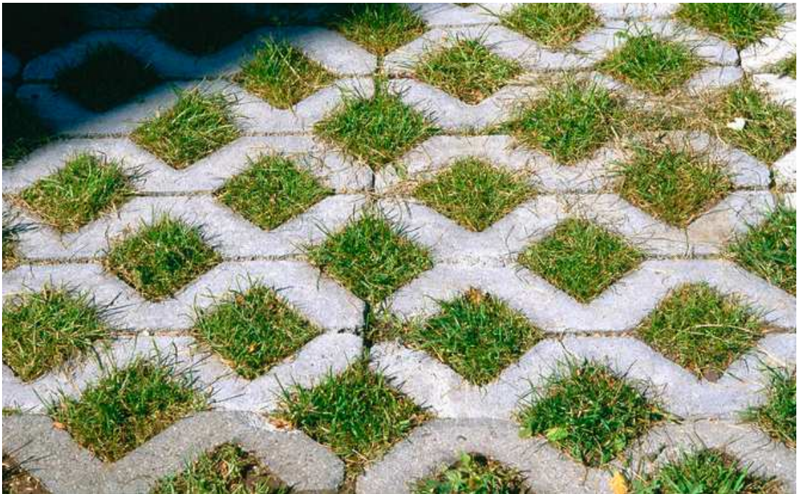
Abbildung 5: Schotterrasen mit Rasengittersteinen
