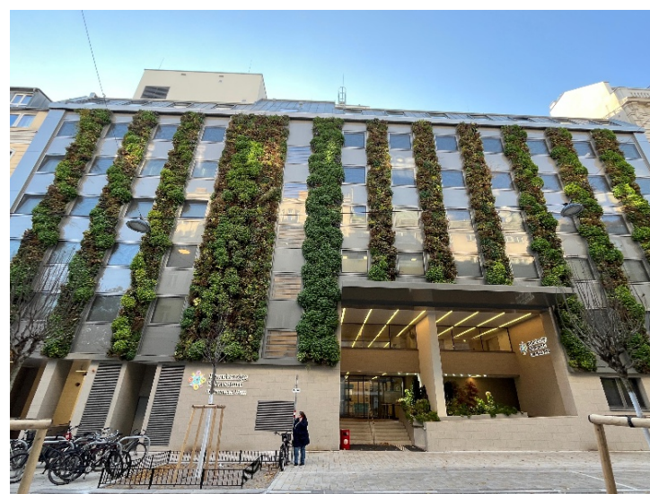
Fassade der Barmherzigen Schwestern in Wien, Margareten
